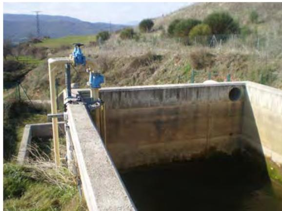
Depósito de recepción de agua de lavado y purgas de fangos, instalación de pasarela de tramex y barandilla perimetral.
