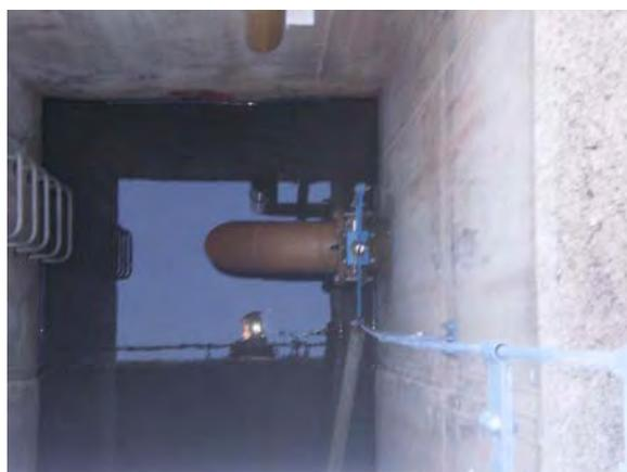
Arqueta salida fangos del decantador, colocación de tramex, campana anticaídas y nueva válvula con husillo.
